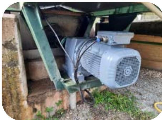
Renouvellement du motoréducteur de l'aérateur de la station d'épuration
